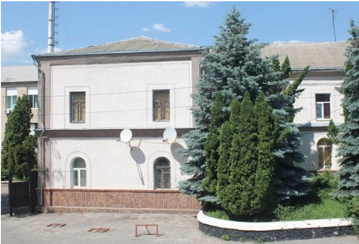
Будівля хоральної синагоги, нині РВВС
